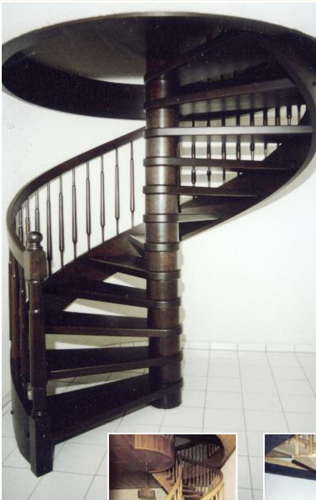
Treppe aufgesattelt, offen, gezogene, schichtverleimte Wangen und Handläufe, mit gedrehten Stäben und Pfosten, schlichter Handlauf.
